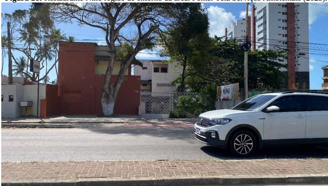
Figura 21: Restaurante Nino região de entorno da área. Fonte: Teia Serviços Ambientais (2025).
