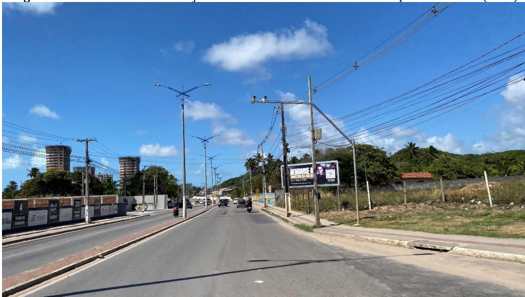
Figura 81: Trecho da via com sarjetas e boca de lobo. Fonte: Teia Serviços Ambientais (2025).
