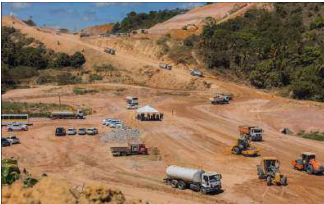
Figura 42- Obras de requalificação e duplicação da rodovia AL-101 Norte, no litoral norte de Maceió/AL.
