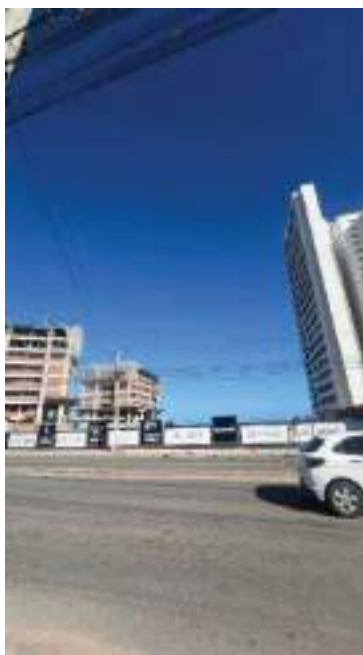
Figura 49- Abastecimento de Energia no Píer Norte Residence.
