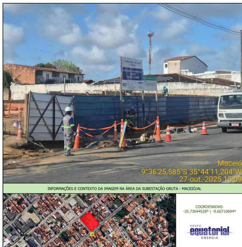
Figura 28: Empresa de saneamento efetuando manutenção em área em frente à SE. Mais ambiental (2025).
