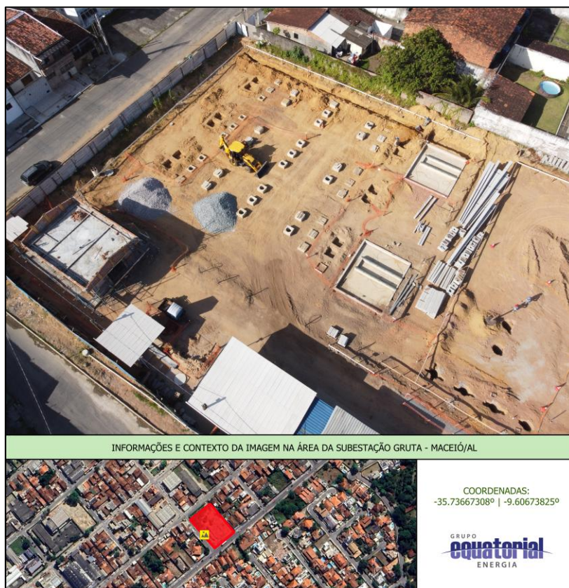
Figura 3: Imagem aérea da SE.
